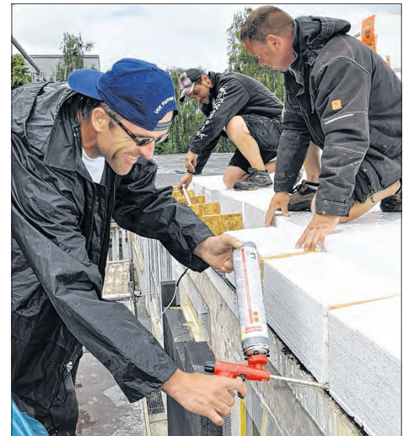
Selbst am Sonnabend wird auf dem Montessori-Dach gearbeitet. Wolfgang Schneider (von links), Steve Nordmann und Michael Höhne dämmen im Auftrag ihrer Firma das Dach.
